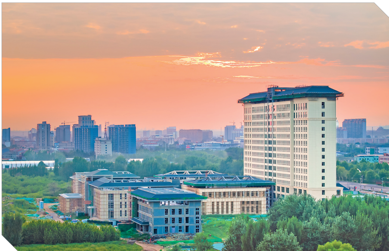
▲稷山县人民医院新院建设项目全景图
