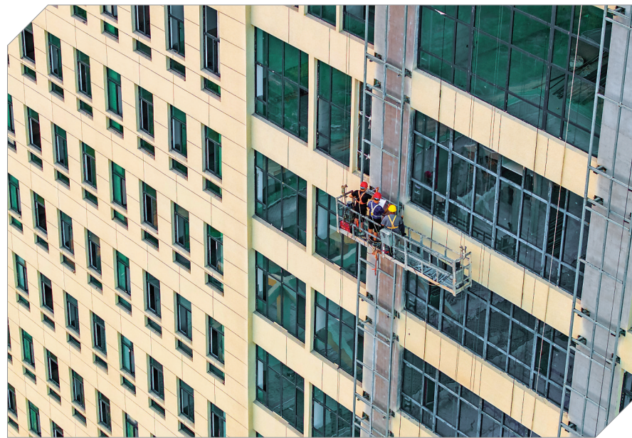
▲项目施工现场
