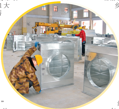
▲组装新风系统风管
