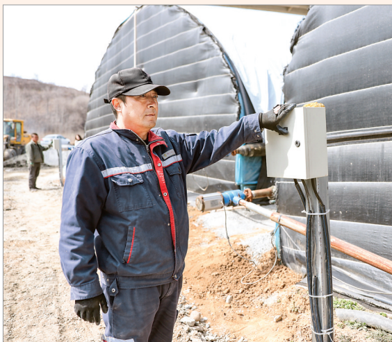
▲工人通过控制大棚门做好通风换气工作
