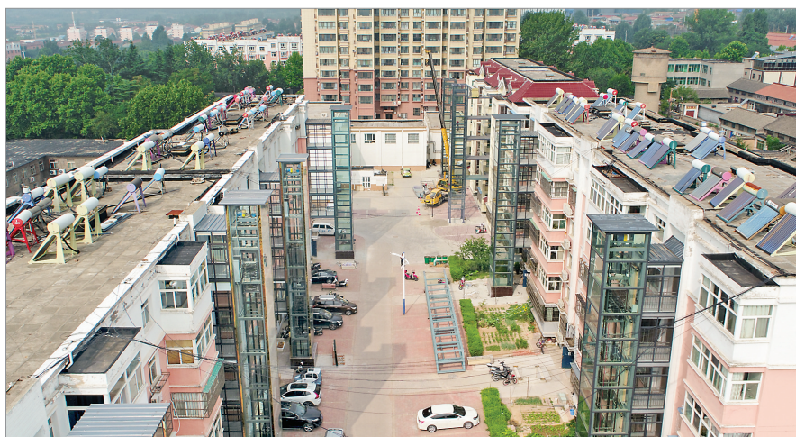
▲垣曲县新建北区加装电梯施工现场
