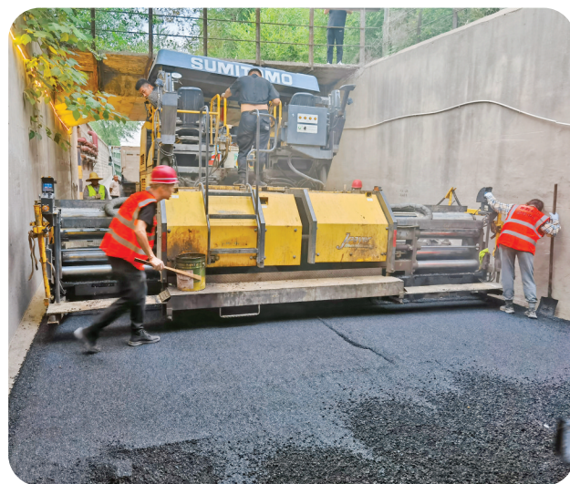
▲路面修复施工现场
