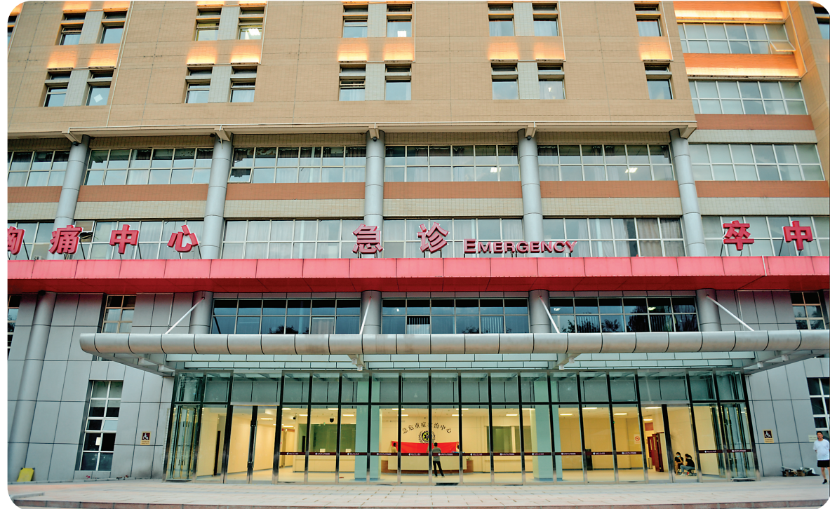
改造完成的门诊三楼区域、急诊大厅、公共厕所
