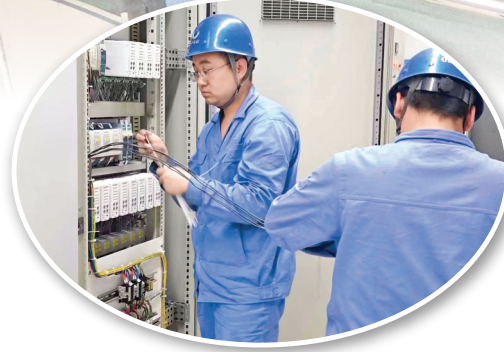
◀ 工作人员检修设备
