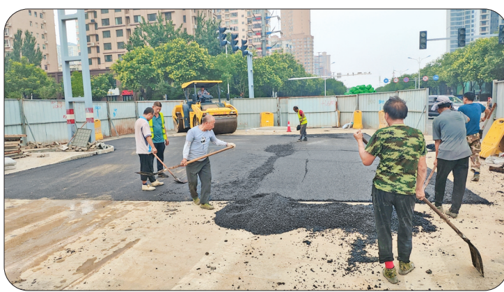
▲道路铺油施工现场
