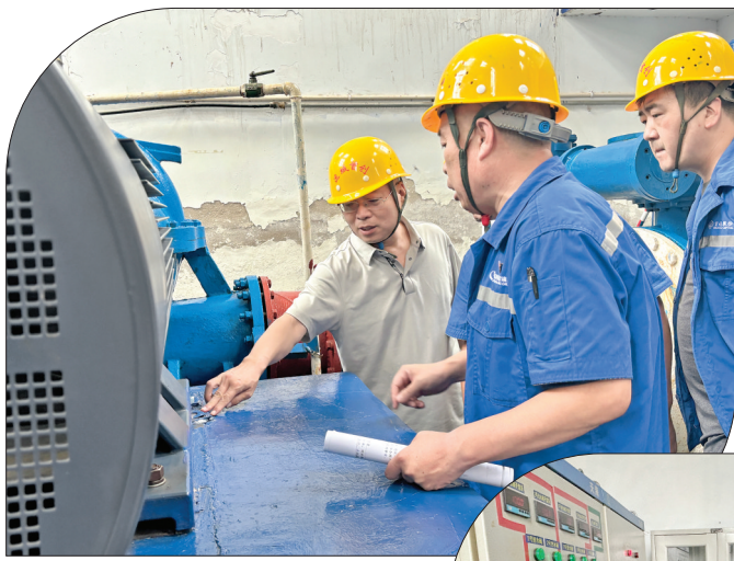
▲设备维修保养
