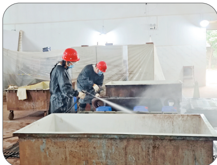
▲ 清洗换热器板片
