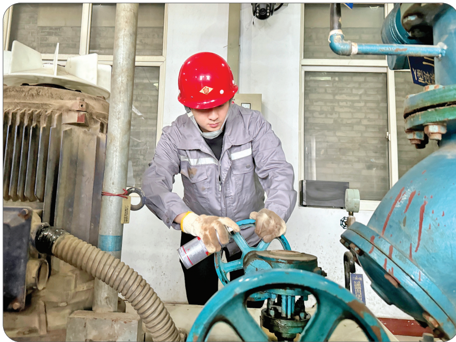
▲ 换热站设备维护保养
