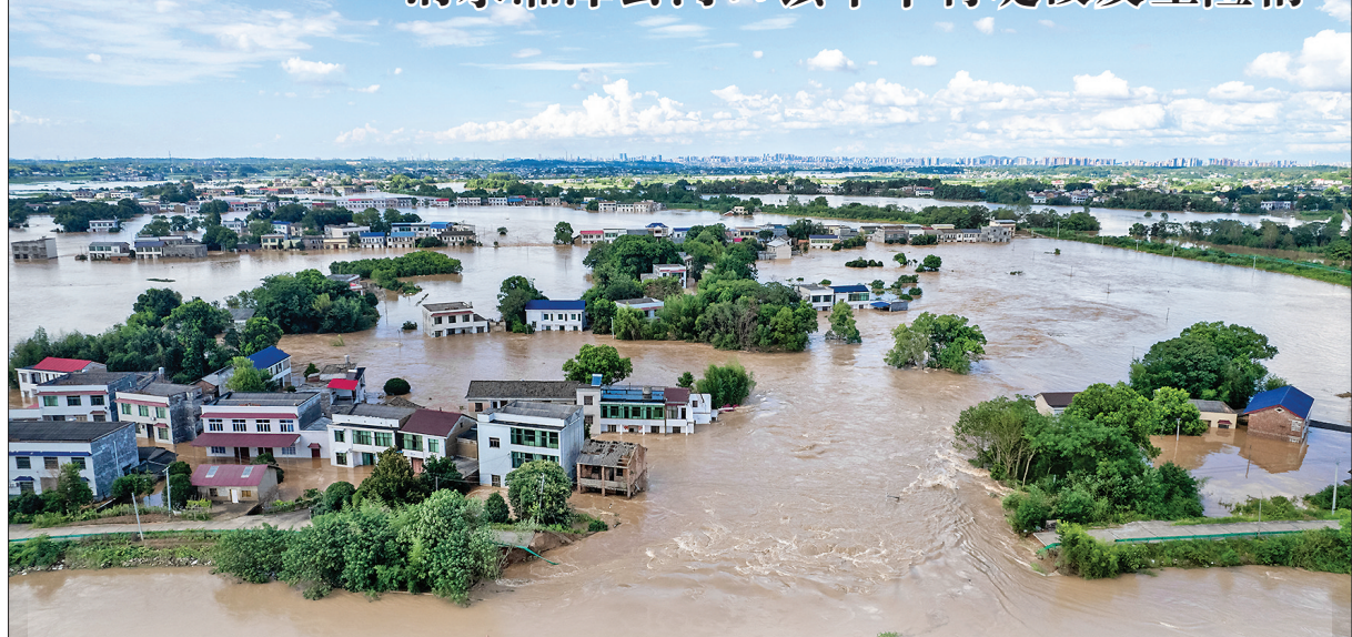
这是7月29日拍摄的涓水湘潭县河口镇华中村堤段决口险情现场。记者从湖南省应急指挥中心获悉,7月29日13时40分许,涓水湘潭县河口镇华中村堤段发生决口,长度30余米。目前,人员转移、抢险除险工作正在紧张进行。 新华社记者 陈思汗 摄
