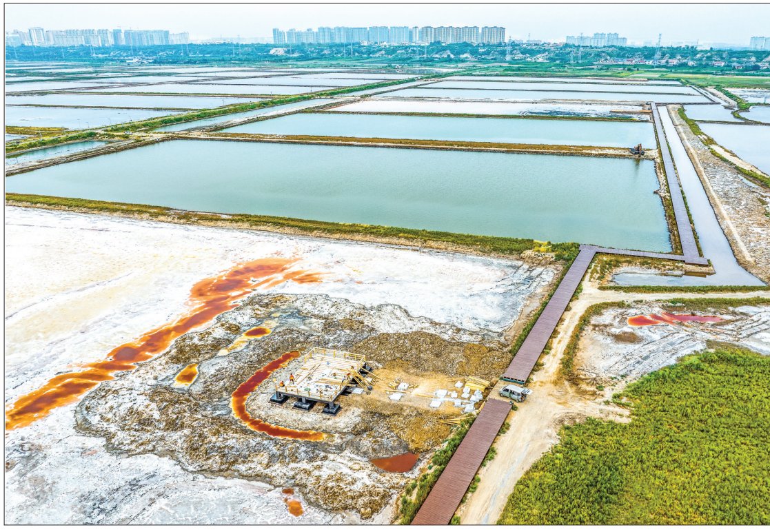
▲9月9日,施工人员在运城盐湖加紧建设观景台。
