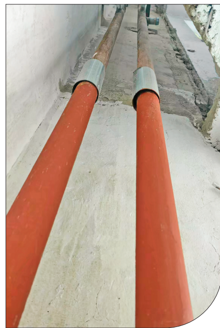
▲新更换的入户管道
