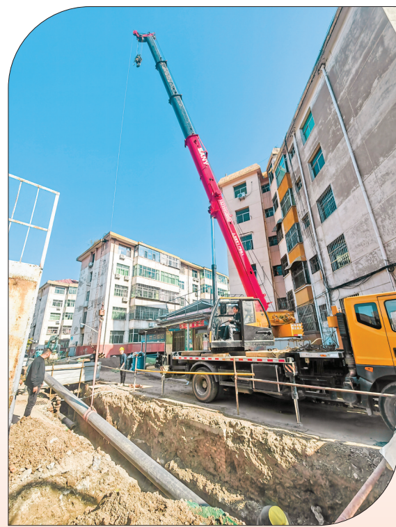
▲施工人员操作吊车铺设管道
