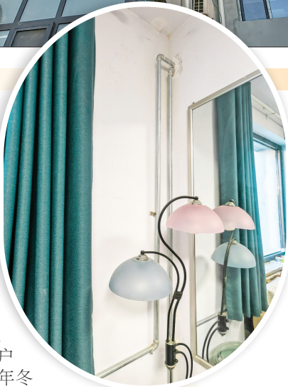
▲居民家中新安装的供热管道
