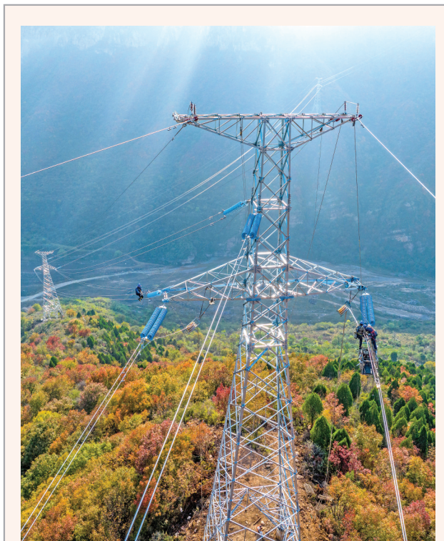
▲10月25日,施工人员在夏县境内的电网铁塔上加紧架线施工。该线路全长96公里,新建铁塔267基,途经平陆、夏县、垣曲3个县10个乡镇。工程建成后可进一步优化电网结构,从源头上提升电网防灾抗灾能力。
