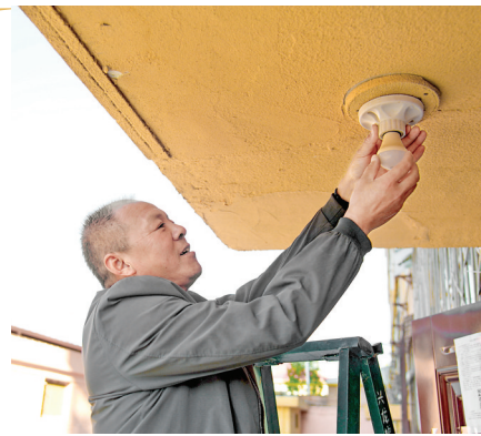
▲物管会人员检查灯泡
