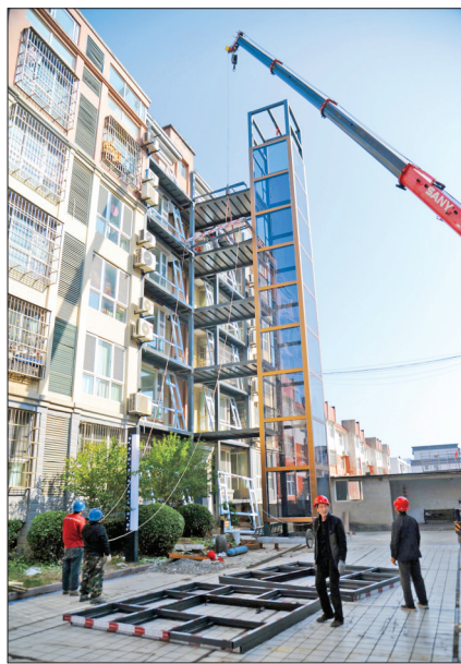
电梯加装施工现场
