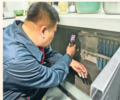
▲监测分水器进回水温度
