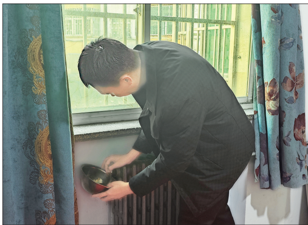
▲为市民家中暖气管道排气
