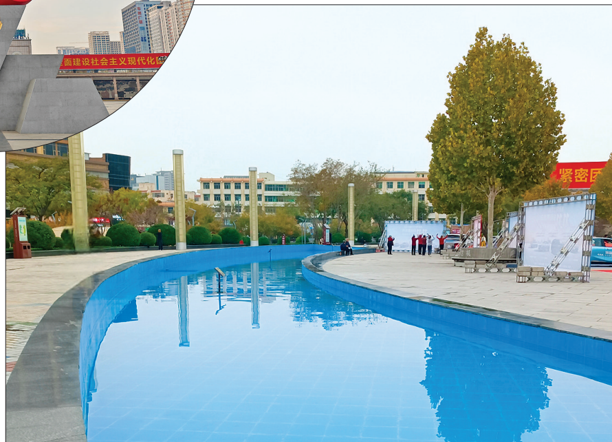
▼翻新后的景观水池
