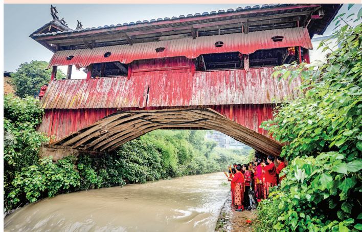
▲村民在浙江省丽水市庆元县古廊桥双门桥参加非遗端午走桥民俗活动(2024年6月11日摄)。新华社发
