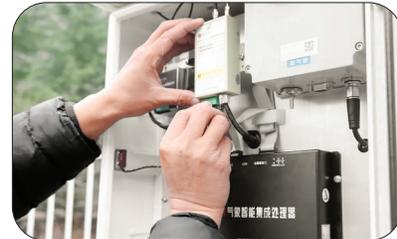
日前，在垣曲县历山镇望仙风景区区域自动气象站安装现场，技术人员正在对气象观测设备进行安装和调试工作(上图)。
