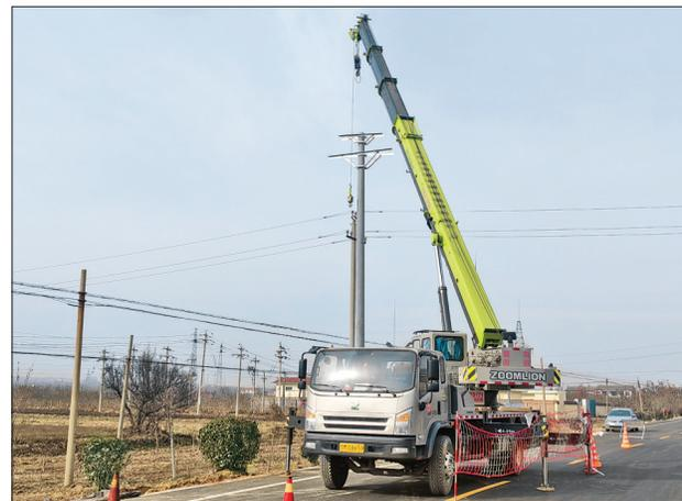
▲工作人员操作吊车架埋电线杆
