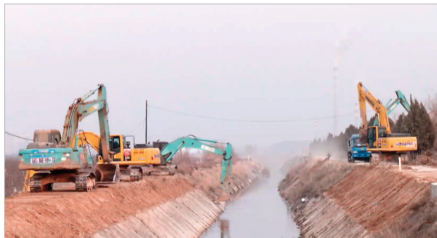
▲姚暹渠提升改造工程施工现场
