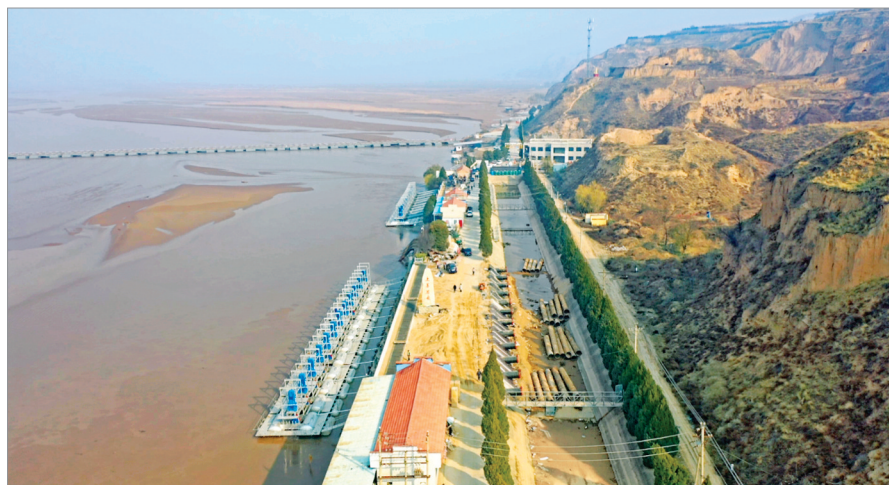
▲夹马口引黄灌区续建配套与现代化改造工程施工现场
