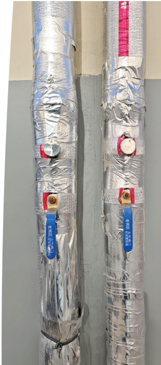
▲单元楼外新安装的供热管网
