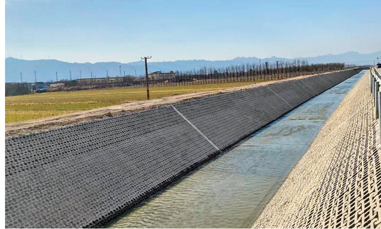
边的农田。此次改造工程对渠底进行硬化和拓宽,渠底由原来的1米多扩展到5米,最宽的地方达到8.5米,口宽达到13米,建成后渠水流量由原来的每秒5立方米达到38.56立方米,可满足中心城区的排水要求。
