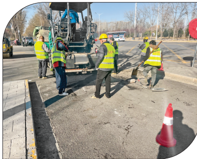
▲修复破损路面
