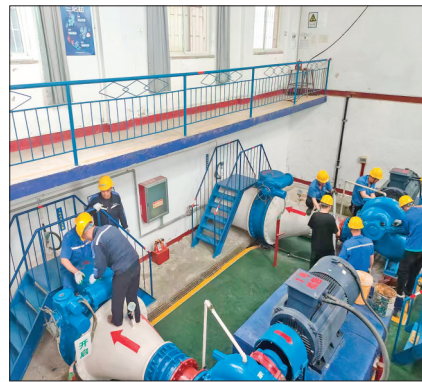
▲永济卿头加压泵站设备检修
