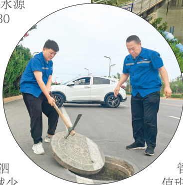
◀检查供水管线排气阀
