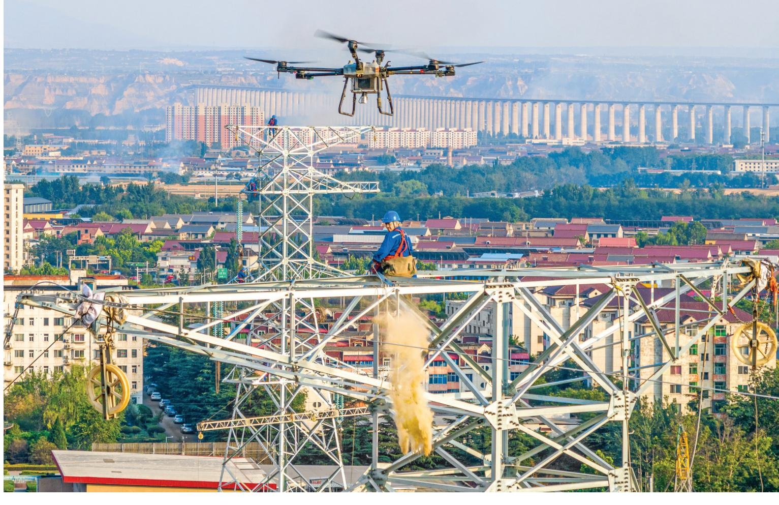
▲6月11日，在河津西220千伏输变电工程现场，国网运城供电公司施工人员正利用无人机放线作业。
