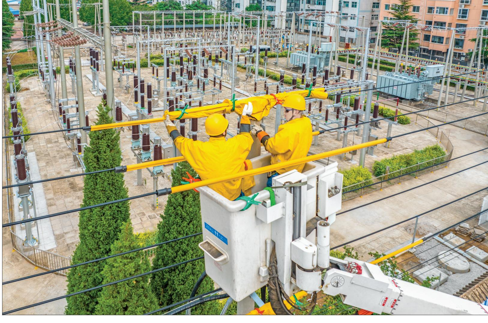
▲7月15日，国网山西省电力公司平陆县供电公司工作人员在10千伏526韩窑线东韩窑村支线3号杆，进行带电接火。近期，随着气温持续升高，用电负荷也随之攀升。为保障迎峰度夏期间电网稳定运行，国网山西省电力公司运城供电公司加强设备运维，进行带电作业，全力保障居民可靠用电。
