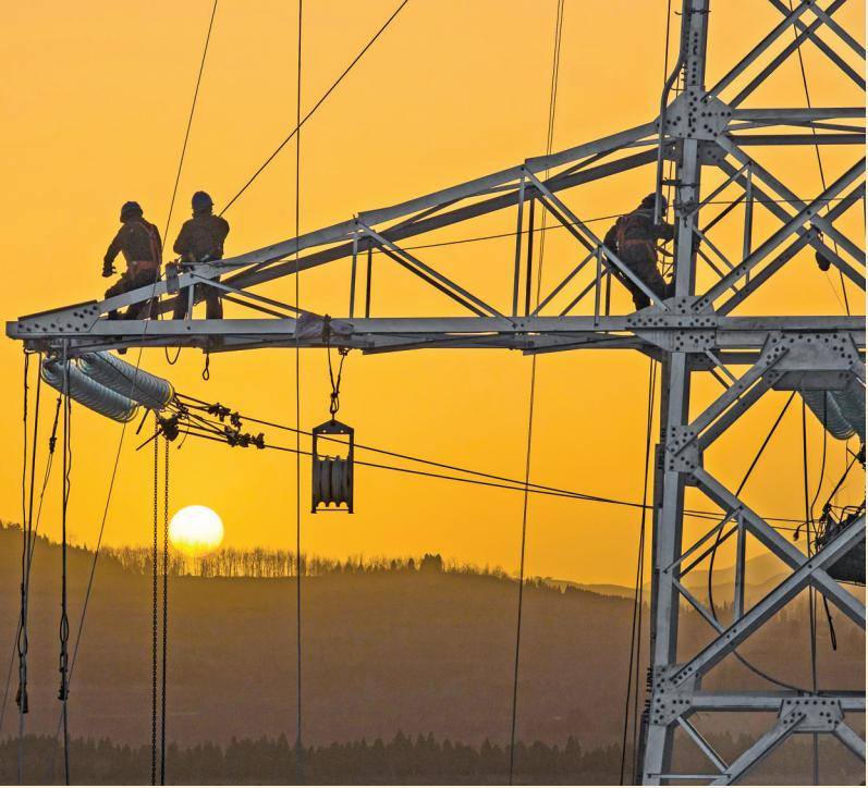
▲11月24日,国网运城供电公司施工人员在山西运城220千伏桃平一二线防冰改造工地进行导线紧挂线作业。
